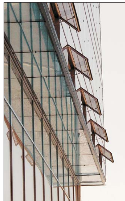
ORI 70/SI Brandventilator med fönster för väggmontage, Shopping Center Iso Omena, Esbo, Finland
